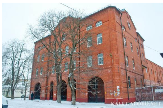
Рис. 30 Здание на ул.Билибина 33А
