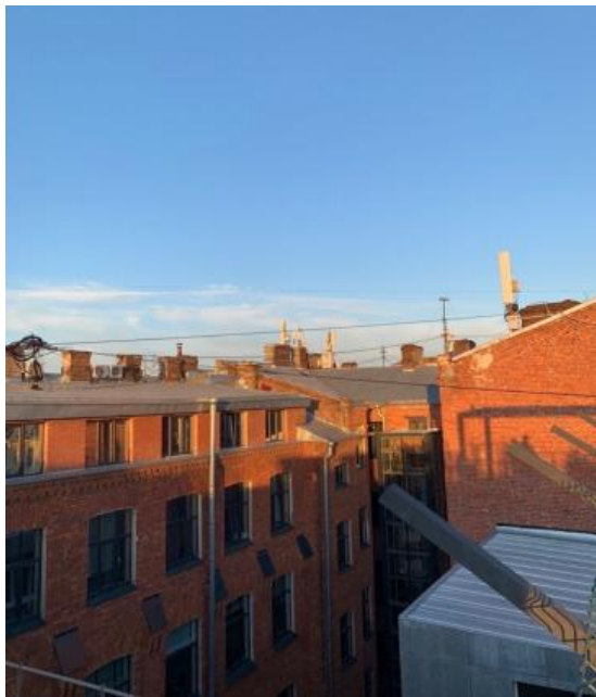
Рис. 42 Выход на крышу
